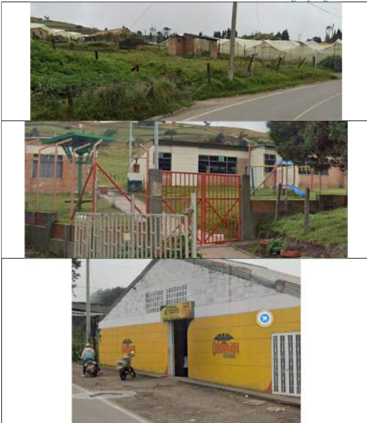
Ilustración 135 Construcciones de la Zona A dentro del DMI Páramo de Guargua y Laguna Verde
