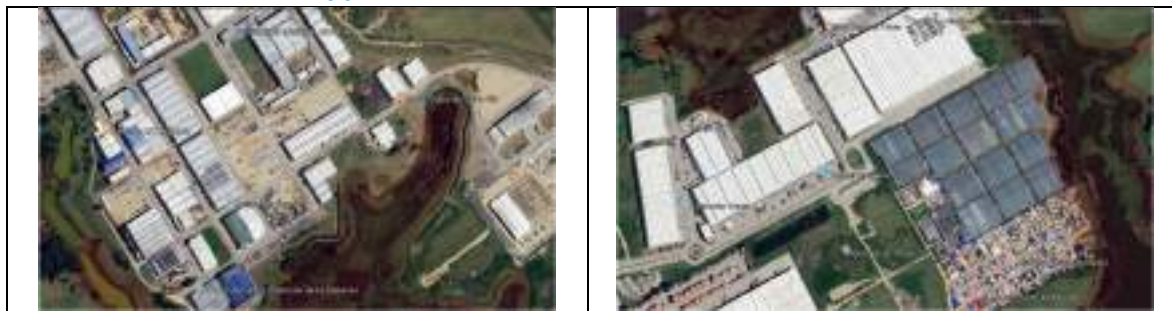
Ilustración 256. Actividades ubicadas cerca al RH Humedal La Florida
