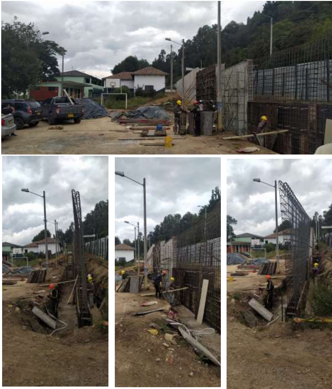
Gráfica 29 Estado de la obra 2021. Muro de Contención vereda Carrasquilla. Tenjo.
